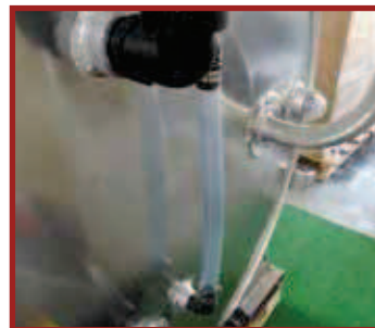
Tubo de nivel para comprobar el nivel de agua limpia
