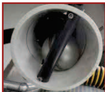
Cierre de desbordamiento primario con bola de acero inoxidable
